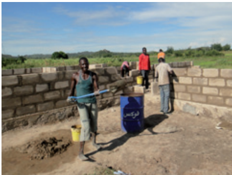
Hilfsprojekt Mr. Masalu: Ein neues Haus entsteht.
