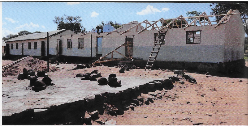
Neu- und Umbau der Schule beinahe abgeschlossen
