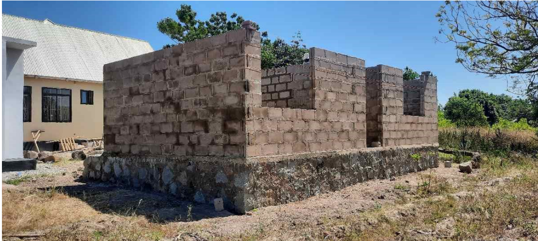
Rohbau auf festem Fundament direkt neben der Krankenstation .
